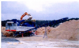
田川市鉱害復旧工事 (鉱害復旧事業団) コンクリート破砕中間処理
