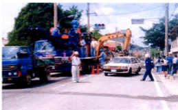
直方市市道 (直方市) 市道アスファルト破砕 中間処理状況
