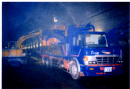
九州新幹線桑川内トンネル内 (清水・三井・東洋共同企業体) 仮設道路(アスファルト) 破砕中間処理状況
